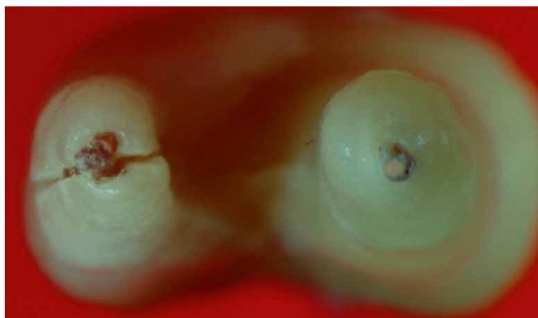
شکل ۴-۱۲: شکستگی عمودی ریشه در قسمت باکال ریشه یک پرمولر دوریشه ماگزیلاری. VRF کامل با جهت باکولینگوالی که به ناحیه دوشاخه شدن ریشه گسترش یافته، نشان داده شده است
